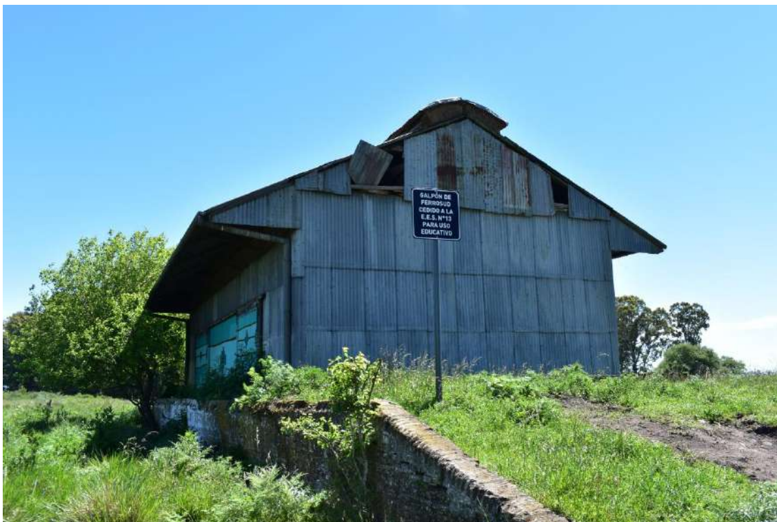
Imagen 1: Galpón de Ferrosud cedido a la Escuela Secundaria Nro. 13
