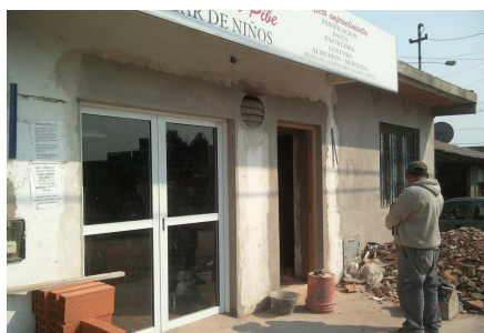
Instalaciones en plena refacción
