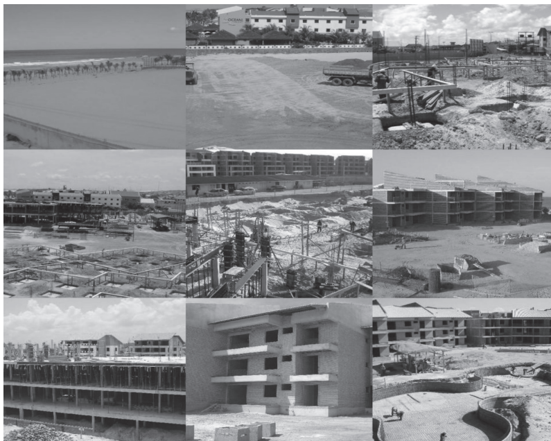
Figura 3: Evolução das Obras do Paraíso das Dunas Residence. Fonte: www.cameron.eng.br (acesso em: 02/11/2008).
